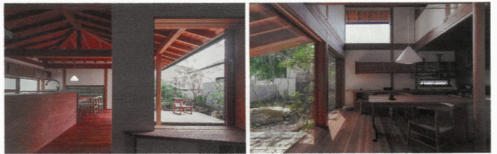
木の架構が見える真壁づくりの空間には、大工の手しごとや天然乾燥した無垢材の美しさがおのずと表れる。職人の技術や山の文化を継ぐ理念が設計思想に溶け込んでいる
